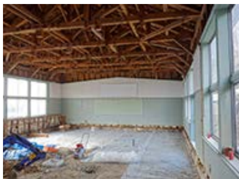
大きな理科室は、造校舎2階部分までの天井高がある。この全面を金属製のパネルで覆い、酒の仕込部屋に。
